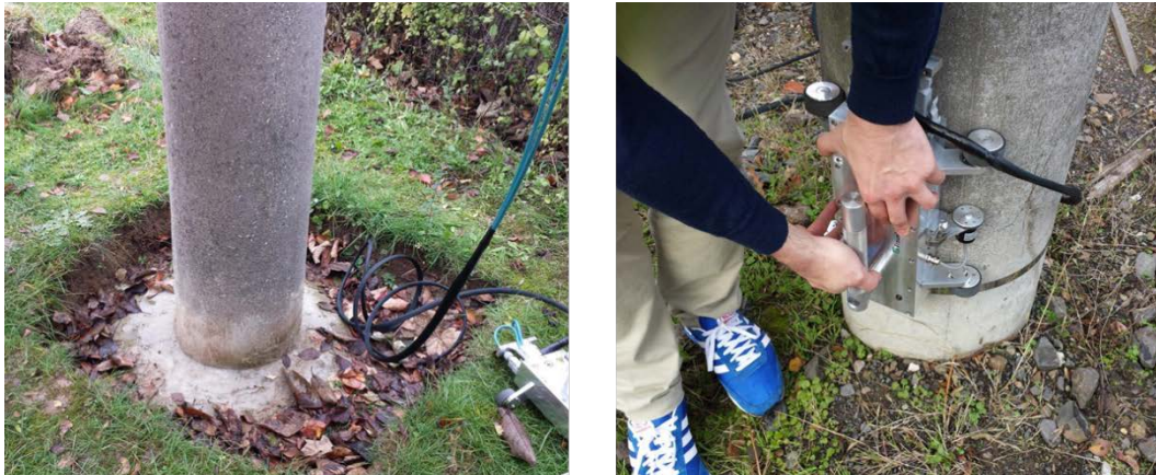
Abbildung 12: Notwendige Vorarbeiten zur Messung im Erdnahen Bereich (links) und Handhabung des Prüfsystems »BetoFlux« (rechts)
