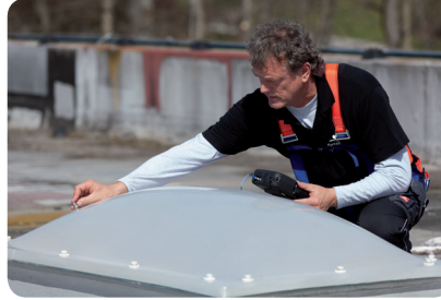
Messung der Schichtdicke der „KEMPEROL FALLSTOP“ Beschichtung mit dem Wanddickenmessgerät 38DL Plus und dem Ultraschallmesskopf V202 (Videoscan; Frequenz: 10 MHz; Elementdurchmesser: 6,35 mm; mit Kunststoff-Vorlaufstrecke)
