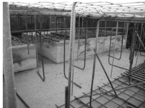
Abbildung 2: „Innenansicht“ vor der Betonage [7]
